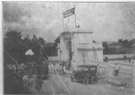
Entrada principal del nuevo sanatorio del Centro Balear inaugurado el pasado domingo.
